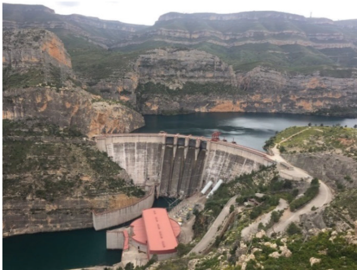
Fig. 1. Centrala hidroelectrică cu acumulare prin pompaj Cortes-La Muela [1]
